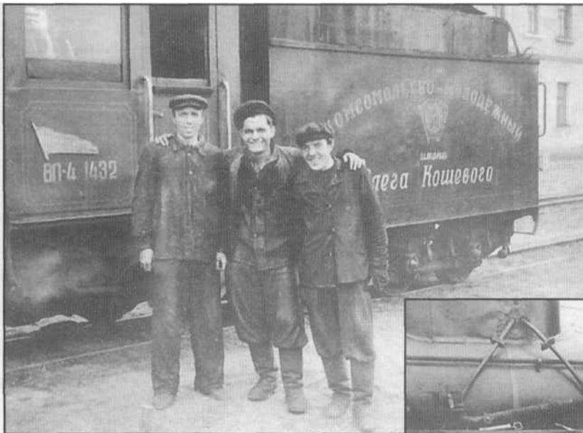
В послевоенное время на узкоколейке торфопредприятия «Палец» работали паровозы ВП-4, а также паровозы финского и чешского производства. На этих архивных кадрах запечатлен паровоз ВП-4 с искрогасителем на трубе. На фоне финского паровоза сфотографировались машинист Фирсов А.Д. (в центре), пом. машиниста Денисов и кондуктор Лихачев.... Фото из архива брянского военно-исторического клуба «Арсенал»
