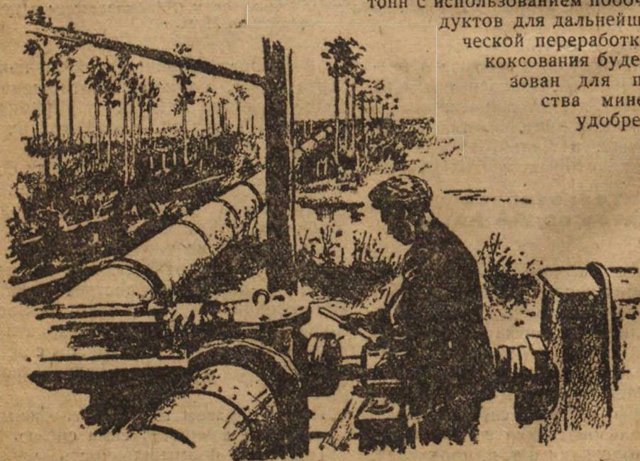
*Гидроторфяная масса по трубам, при посредстве специальных насосов, разливается по полям для сушки*
