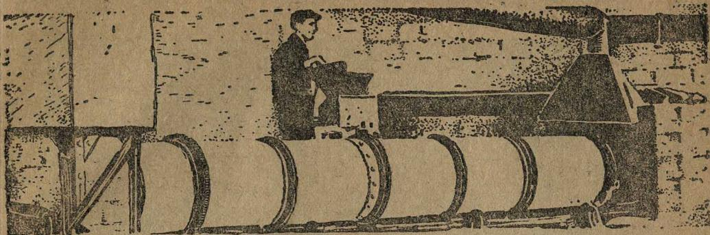
Опытная цилиндрическая вращающаяся печь для восстановительного обжига железных руд на испытательной станции „Механобра“. К лабораторию исследованию методов обработки керченских и криворожских руд
