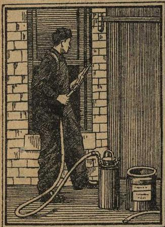
электродвигателей. Весь аппарат состоит из стального полого цилиндра, содержащего ту пластическую массу, которую надлежит впредать в те или иные швы. Вверху цилиндра расположен специальный клапан, надетый на шланг с насаженным на конце соплом; цилиндр оборудован также предохранительным клапаном. Для необходимого напора обыкновенно здесь применяется жидкая углекислота. Способ, помимо быстрой работы, дает очень большую экономию в материале, чистоту отделки, простоту и не утомителен для рабочих.
