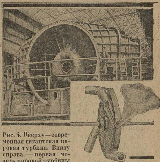
Рис. 4. Вверху—современная гигантская паровая турбина. Внизу справа,— первая модель паровой турбины Лавала.
