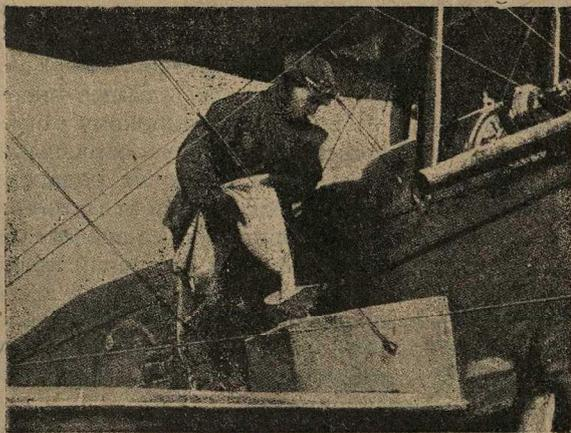
Рис. 2. Опыты осаждения облаков назлектризованным песком в С. Америке. Насыпка чистого кварцевого песка в резервуары аэроплана, где он заряжается положительно или отрицательно поворотами рычага особого прибора.
